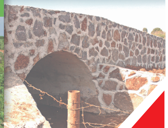
Puente "El Comedero".
